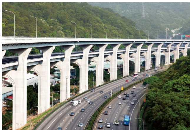
泰山林口雙層橋-3
