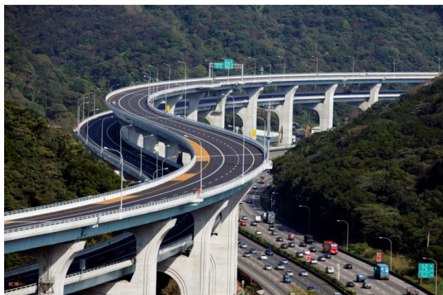
泰山林口雙層橋-1
