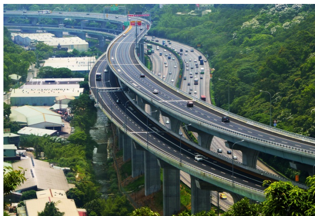
泰山林口雙層橋-4
