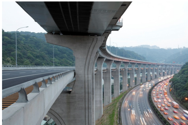
泰山林口雙層橋-2
